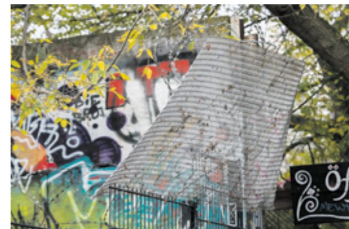
Reste von Streckgitter, mit dessen Hilfe offenbar der Bereich direkt am Ufer der Spree abgesichert wurde. Die Hinterlandmauer endete hier. Befand sich hier auch ein Durchgang für die Grenzer?
