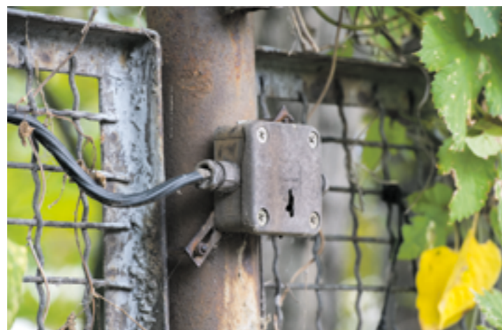
An dem erhaltenen Zaun entlang des Postenweges findet man noch Halterungen der Lampen und selbst Reste der Verteilerdosen. Allerdings ist fraglich, warum die Krone aus Stacheldraht in Richtung des Postenweges geneigt ist und nicht umgekehrt. So wäre er vom Gelände der Eisfabrik aus leicht zu überwinden gewesen, indem man einfach eine Jacke über den Stacheldraht wirft.
