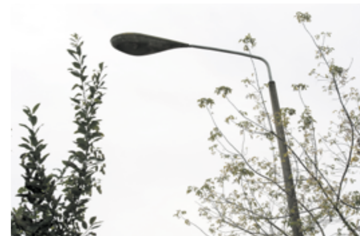
Erhalten sind auch noch Lampen der Lichttrassen auf dem Todesstreifen.
