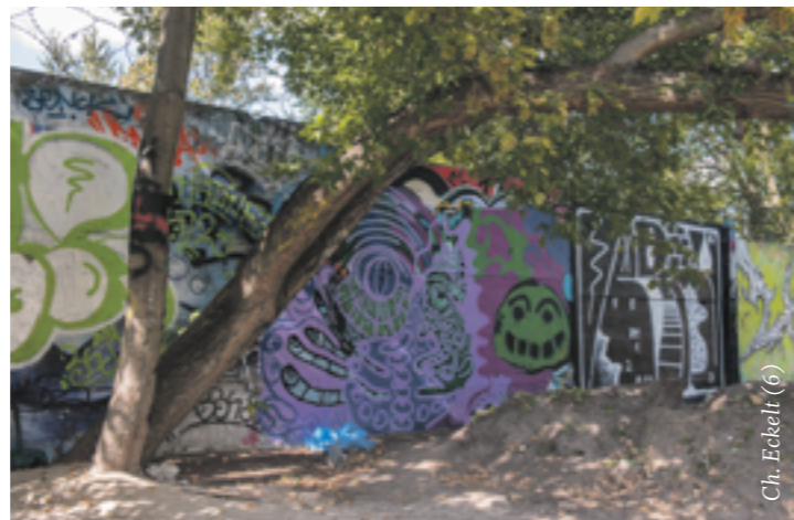
Ein längerer Streifen der originalen Hinterlandmauer steht neben der Eisfabrik. Nur ein Teil davon befindet sich schon auf öffentlichem Gelände, ein weiterer Teil auf einer Fläche, die für das Anlegen eines öffentlichen Uferweges angekauft werden soll. Noch nicht geklärt ist, wie die Mauerreste an dieser Stelle erhalten werden können.
