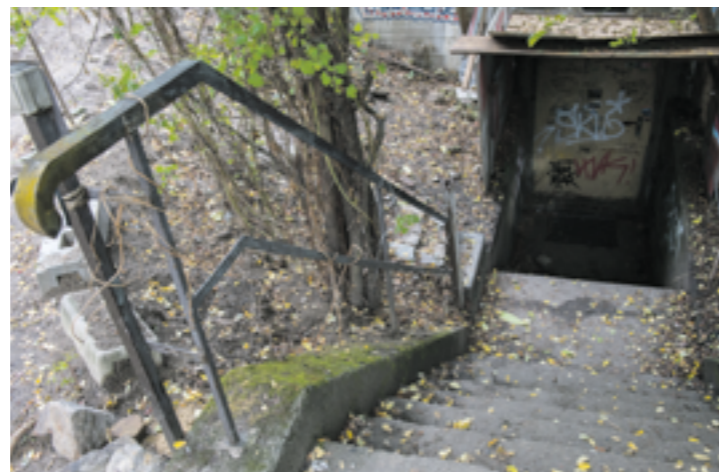
Zum ehemaligen Bootsunker der Grenztruppen führt eine Treppe hinab. Um an dieser sehr engen Stelle einen Uferweg anzulegen, müsste die Treppe verlegt und seitlich nach oben geführt werden.
