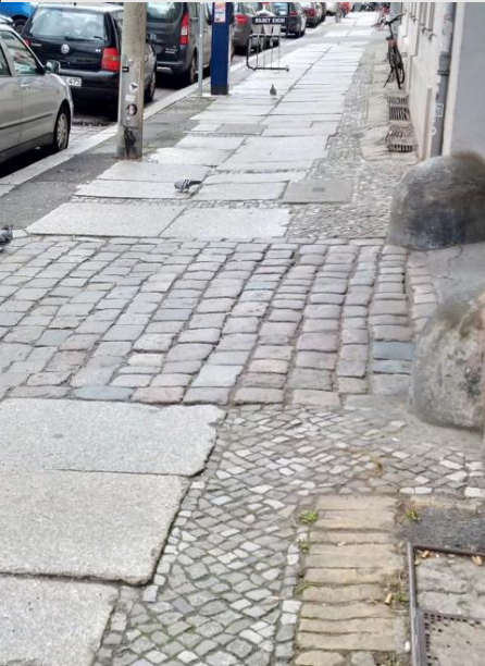
uneinheitliche und provisorisch reparierte Gehwege
