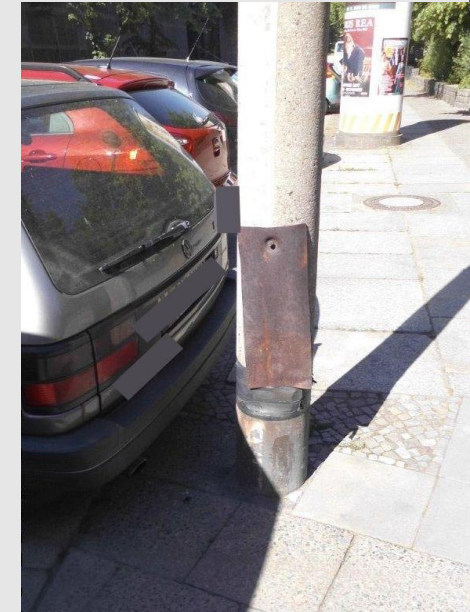
Schadhafte Lichtmaste
