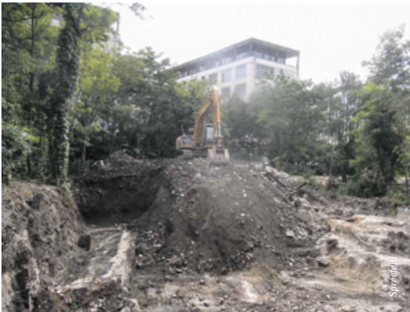
Bei der Erdsanierung gab es eine unangenehme Überraschung: Ein Ziegelfundament aus dem 19. Jahrhundert.
